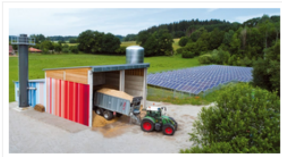
Solares Nahwärmenetz in Moosach. Foto: Naturstrom
